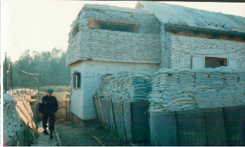
Fot. 77. Wykorzystanie worków do ochrony budynku.
