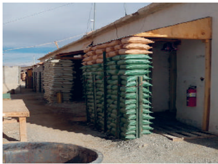
Fot. 78. Wykorzystanie worków do ochrony wejść do budynków.
